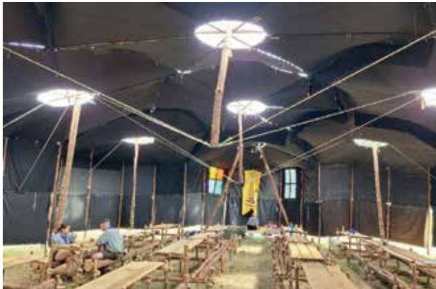
Die fertige Halle mit ihren 2 fliegenden Mittelstützen
